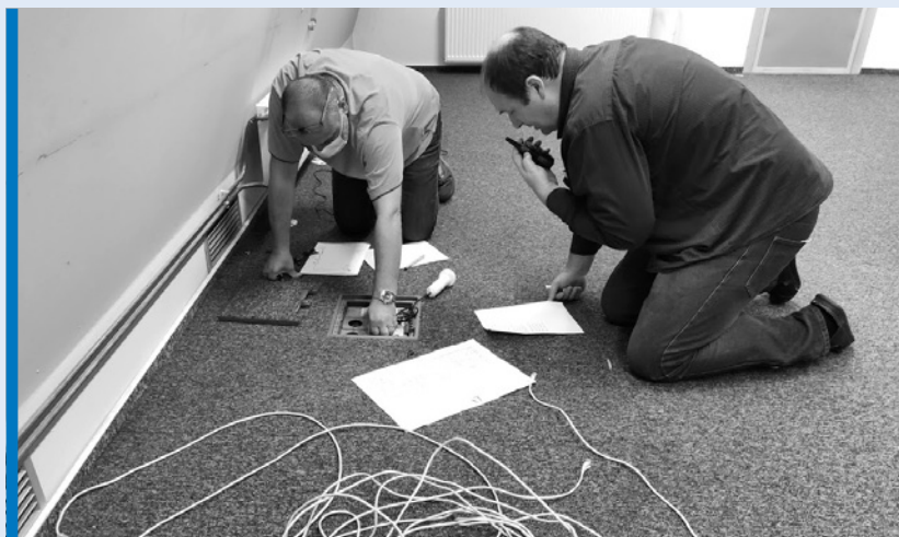
Technici na průzkumu elektroinstalací. Hledají, který drát kam vede a k čemu slouží. Bude to stačit nebo bude potřeba nové přidat?
