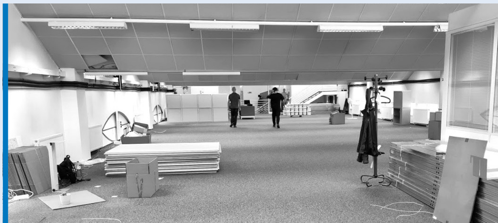
Příprava na budování odbavení a kanceláří – jedni vyklízejí a další přinášejí materiál.
