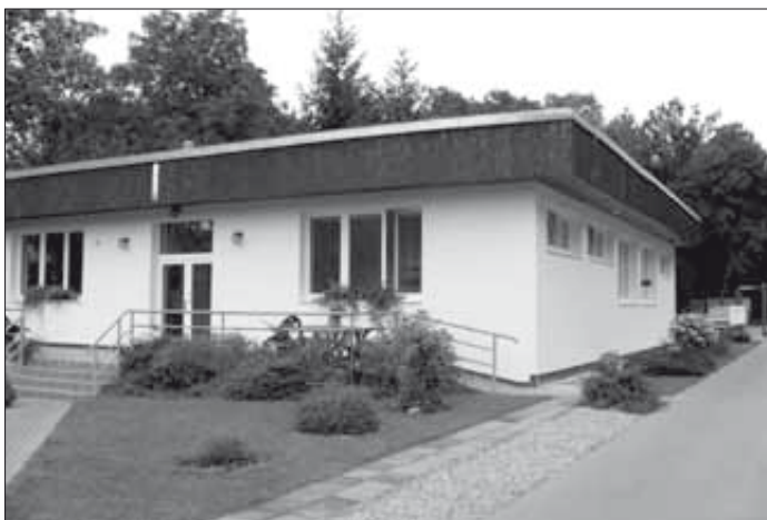
Nová fasáda a zateplení Lesovny
