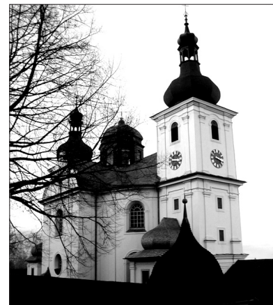
Poutní kostel v Dobré Vodě - stanoviště nového vysílače
